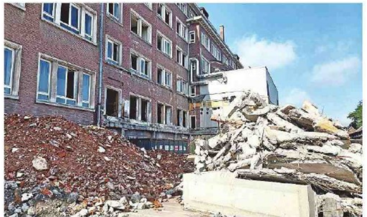
De sloop van het oude ziekenhuis volop bezig. Foto CDR
